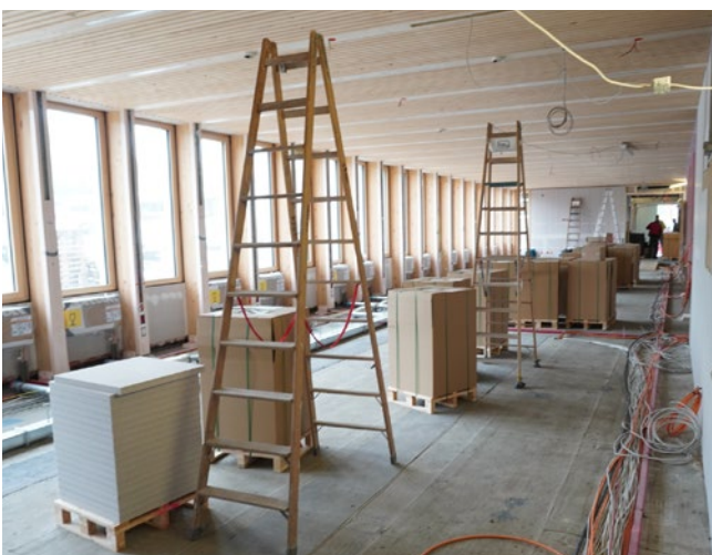
Der spätere Open Space im Erdgeschoss nimmt Form an.
